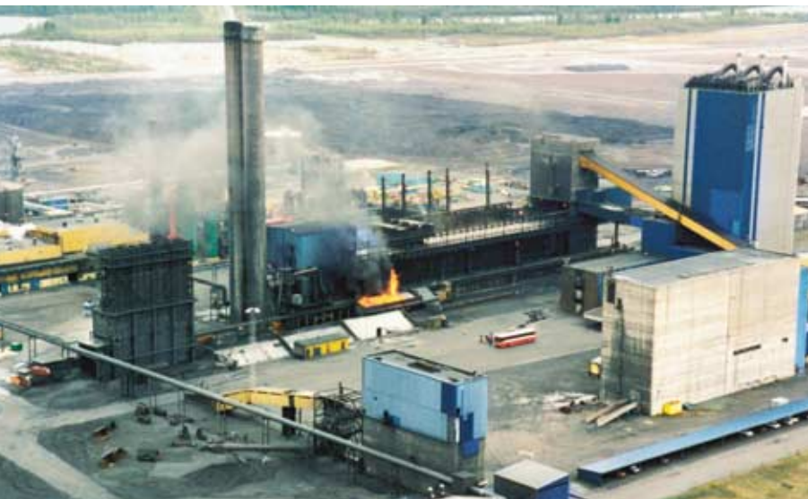
Ylempi kuva: Imuhuuvu muistuttaa suurta laatikkoa. Alempi kuva: Ennen puhdistuslaitteiston käyttöönottoa ilmaan levisi suuria määriä pölyä, kun valmis koksi purettiin.
