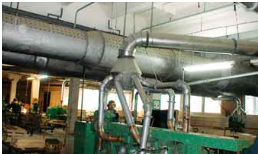
Baltiske virksomheder har med NEFCOs nye låneramme mulighed for at investere i renere produktion. Møbelfabrikken Kauno Baldai i Kaunas, Litauen, har takket være et nyt ventilationssystem kunnet reducere energiforbruget og emissionen af støv og kuldioxid.
