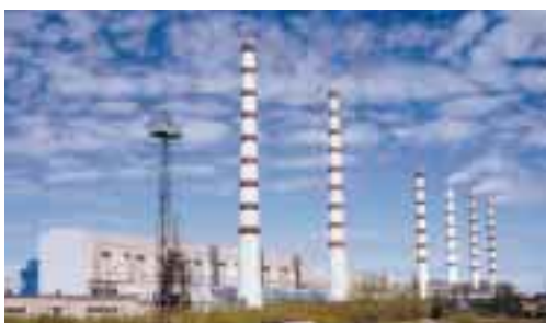
Miljølånet anvendes til renovering af Narvaværkerne.
