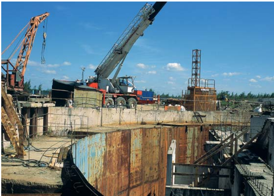
Rakennustyöt aloitettiin jälleen maaliskuussa 2003 ja etenevät suunnitelmien mukaisesti. Puhdistamo valmistuu vuonna 2005.
