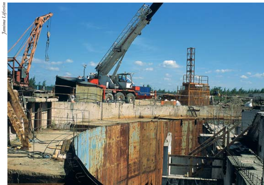
Byggeriet er i gang igen. Arbejdet blev genoptaget i marts 2003, og rensningsanlægget skal stå færdigt i 2005.
