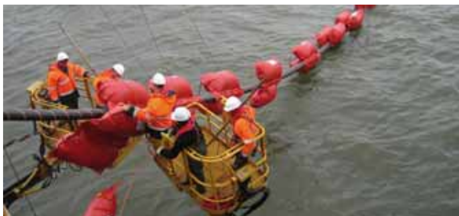
NorNeds högspänningskabel läggs ut i Nordsjön.
