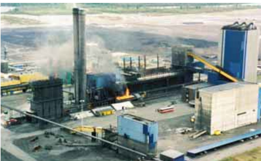
Överst: Utsugshuven har formen av en stor låda. Ovan: Innan reningsanläggningen kom på plats spreds stora mängder stoft i samband med att färdig koks trycktes ut.
