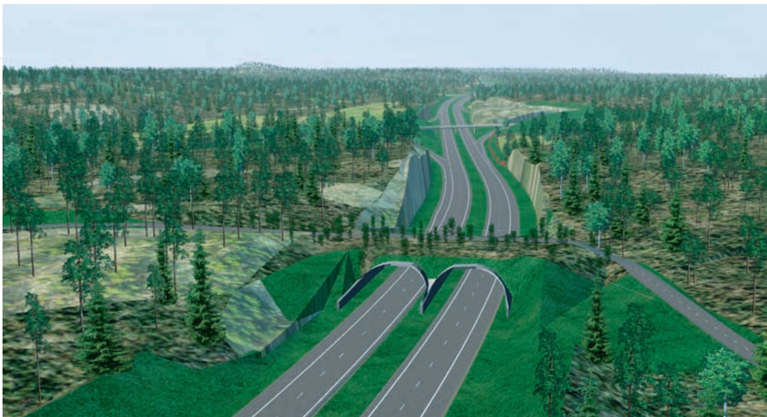
Så fort avtalet mellan Vägförvaltningen och Ykköstie var klart inleddes vägarbetena. Vägen ska bli färdig på tre år.
