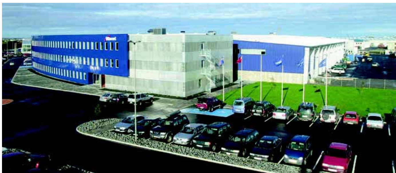
Marels nya byggnad hör till de största fastigheterna för teknisk industri på Island. Här arbetar fler ingenjörer och tekniker än i något annat isländskt företag.
