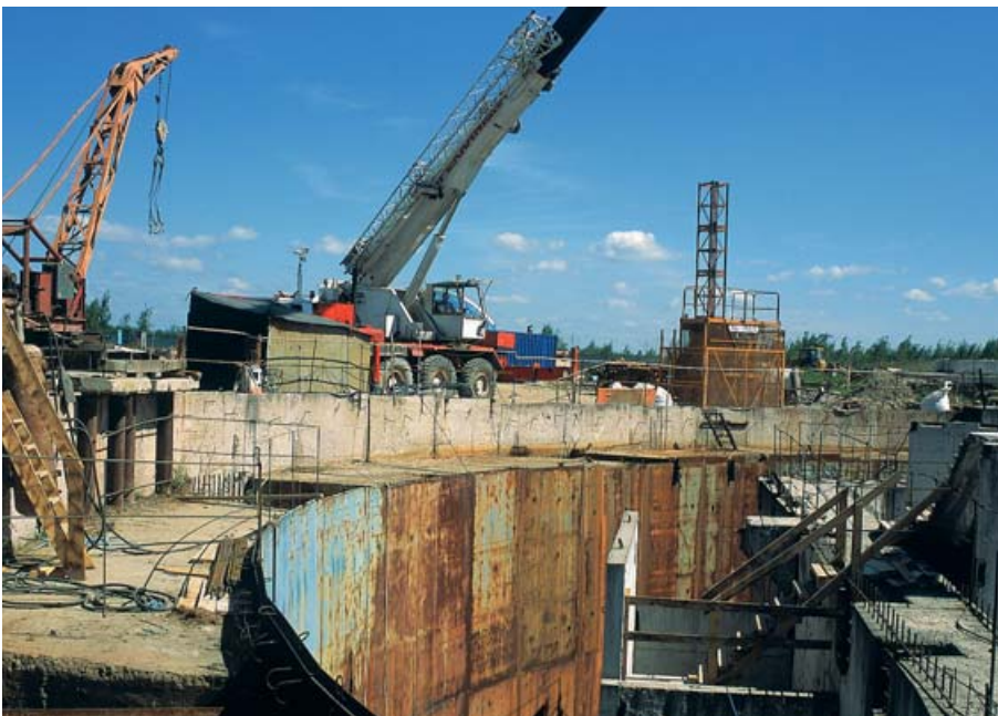
Byggarbetet återupptogs i mars 2003 och arbetet framskrider planenligt. Reningsverket skall stå färdigt 2005.
