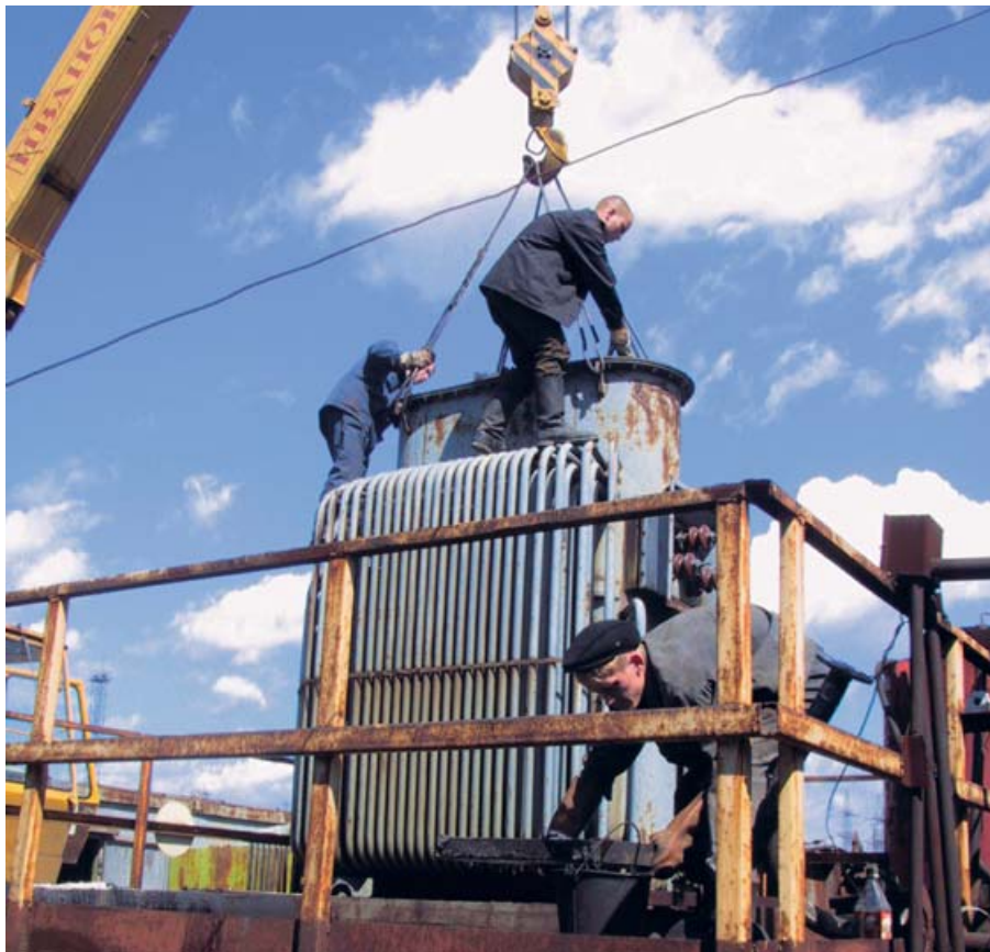
En rysk transformator på väg till vidarebehandling.
